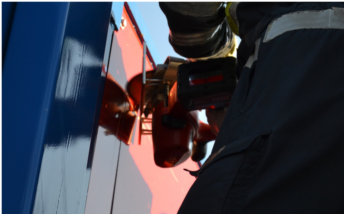
Rys. 348. Wycięcie otworu w tylnej ścianie kabiny przy pomocy piły tarczowej lub piły szablastej
