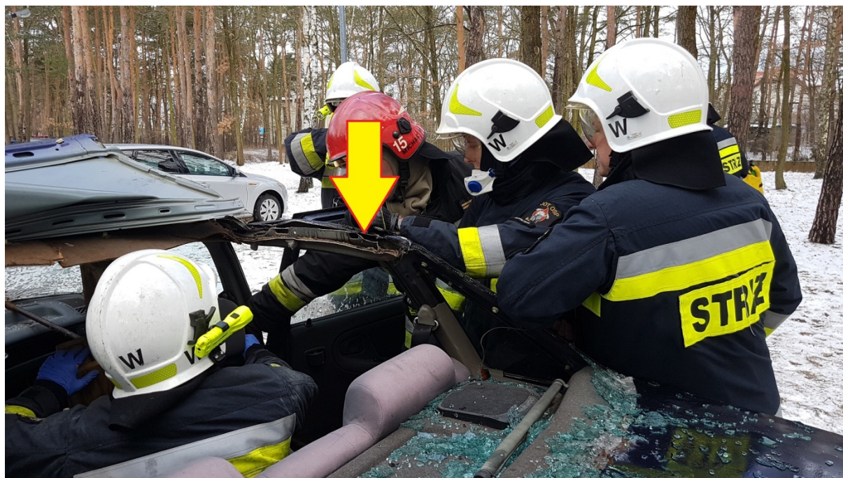
Rys. 290. Jakość uzyskanej przestrzeni po odgięciu dachu ku przodowi UWAGA: W przypadku posiadania przez zespół ratowniczy osłon na ostre krawędzie, należy je bezwzględnie stosować!!!
