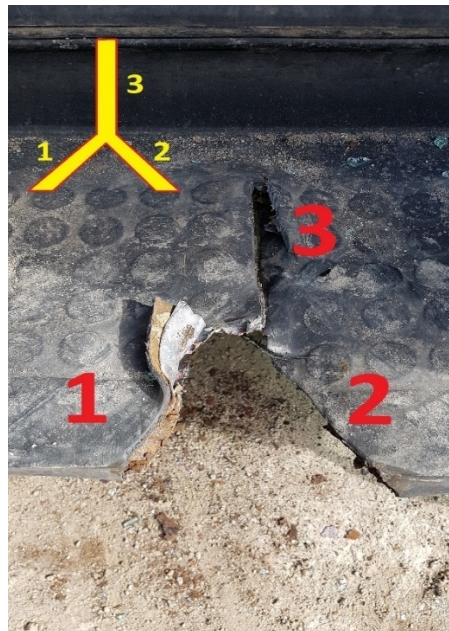
Rys. 411. Nacięcie w podłodze w literę Y
