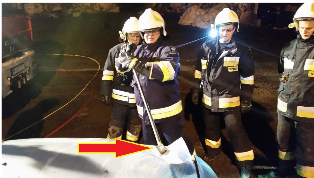
Rys. 331. Uzyskanie szczeliny poprzez odgięcie narzędzia
